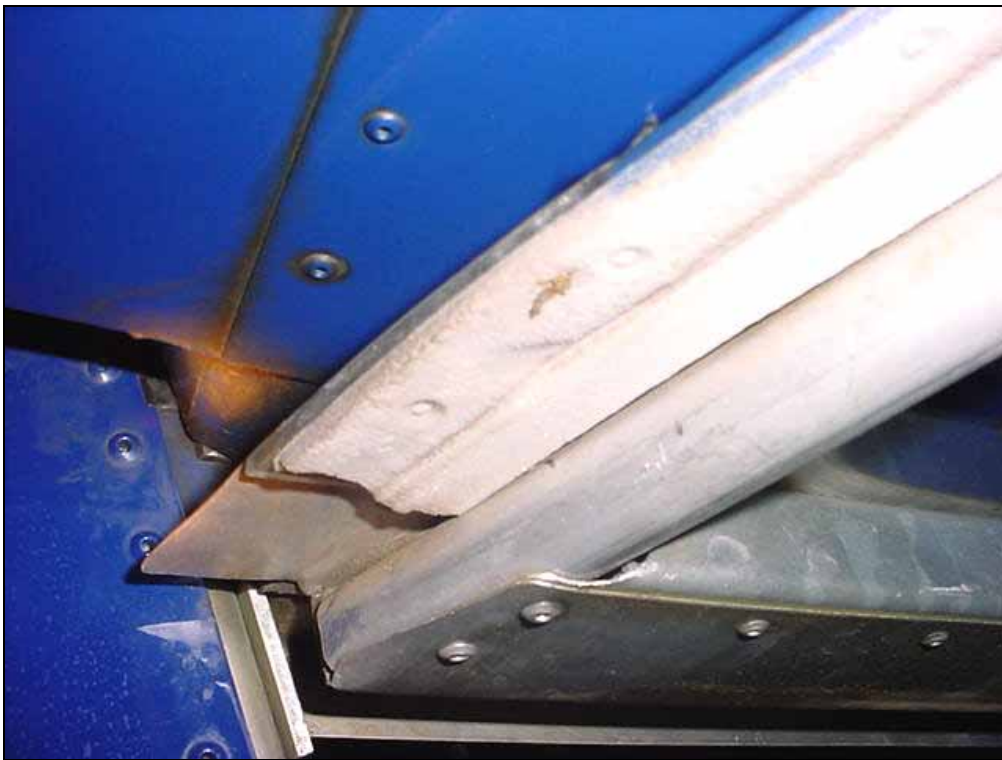
Right door – top aft corner door open
